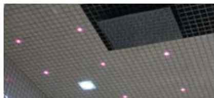
Celkový pohled na strop s osvětlením (5 W - bílé a bodové barevné) a hlavovou sprchou.
